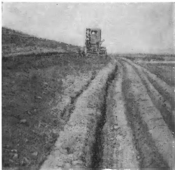
Террасирование склонов «прилапков» под плодовые насаждения
